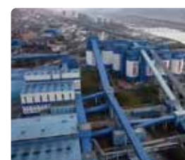
陕西榆林大流塔 煤矿工业园区
