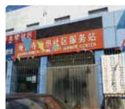
北京市大兴区 观音寺社区 智慧消防改造
